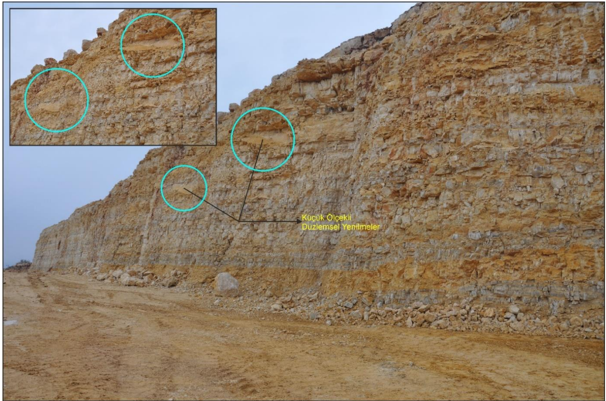
Şekil 97 Güneye bakan şevlerin genel görünüşleri (yaklaşık 190/80 yönelimli şev)
